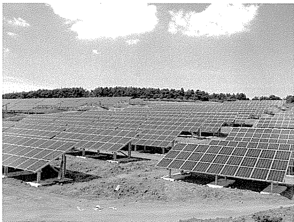
▲ 포철기연이 시공 중인 전남 무안군 1MW 태양광발전소 현장
