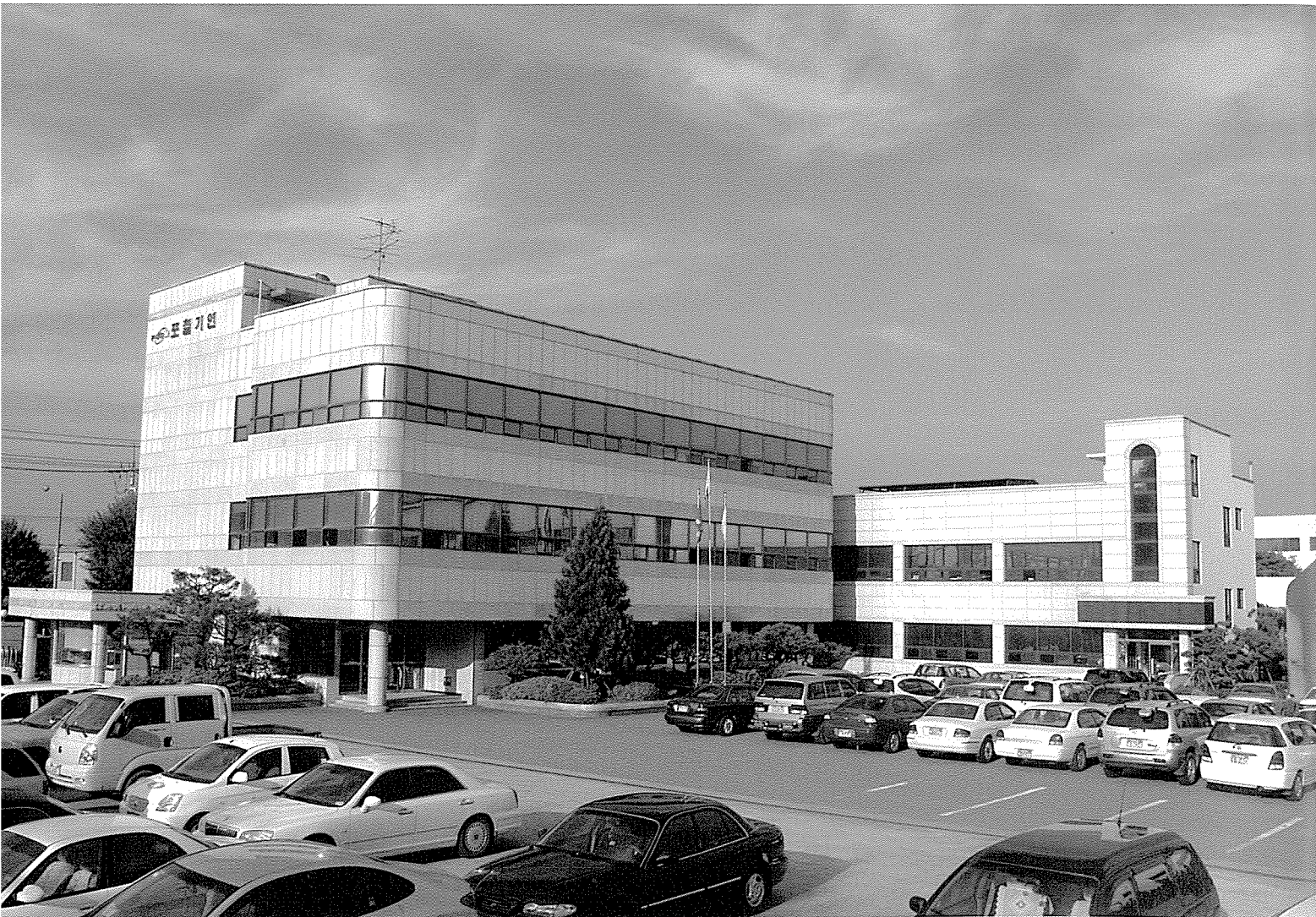
▲ 전남 광양시에 위치한 포철기연 전경
