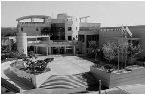
〈신탄진도서관은 총 소장능력 30만권을 기준으로 건축하였다. 현재 개관한지 몇 년되지 않아 도서자료는 약 10만권 가량이지만, 현재 여러칸 일반열람실로 사용하고 있는 공간도 경량칸막이를 제거하도록 설계되는 등 가변적인 구조로 건축된 도서관이다. 도서관 설계 등에 기존 관내(대덕구)도서관이던 안산도서관 사서직 관장이 많은 부분 참여하였다.〉
