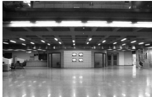
〈한밭도서관 1층과 2층사이에 천정 블럭구조물(박스모양 : 포스트텐션(Post-tention)공법)의 강한 인장력으로 인해 자료실, 열람실 등 실내가 기둥이 없는 구조가 가능해 소장능력 배가 및 가시공간이 넓다. (기둥없는 구조로 자료실 중 큰 것은 약 300평 정도)〉
