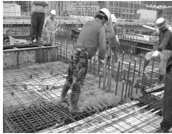
[사진 3] 펌프압송 후 타설모습
