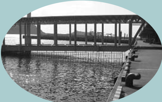
▲ 큐슈지역 나가사키어항의 부잔교식 물양장. 알루미늄 소재의 트러스 지붕을 설치하여 우천시에도 작업이 가능하도록 하고 있다.
