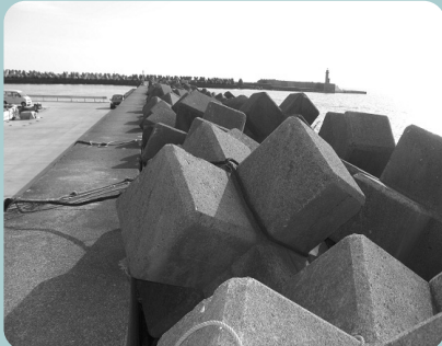
▲ 홋카이도 시라오이군 노보리베츠어항의 방파제 및 소파블록 전경.
