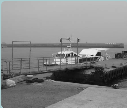
모로자키 어항 - 접안능력의 확보와 낙도를 연결하는 거점항으로서의 시설정비를 실시하였다. 사진은 부잔교 시설
