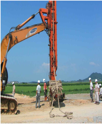
그림 4. 연직배수재 설치 장비.
