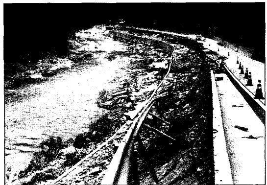
사진 9. 송천 구절리의 도로 피해(2006. 7. 24)
