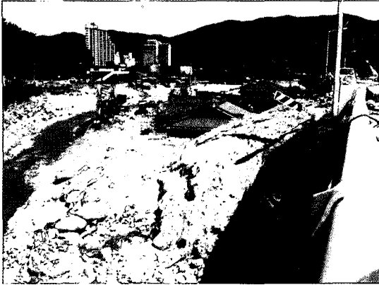
사진 2. 하진부천 사남1교 하류의 토사에 의한 하천 및 가옥 매몰(2006. 8. 4)
