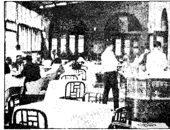
<사진 17> 철거당시 커피테라스
