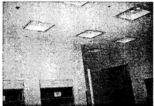
그림 1. 천장매입식 4등용 백열등기구 Fig. 1. Ceiling luminaire for four incandescent lamps
