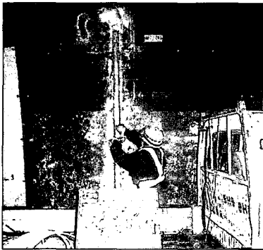
(c) 도수 파이프 설치
