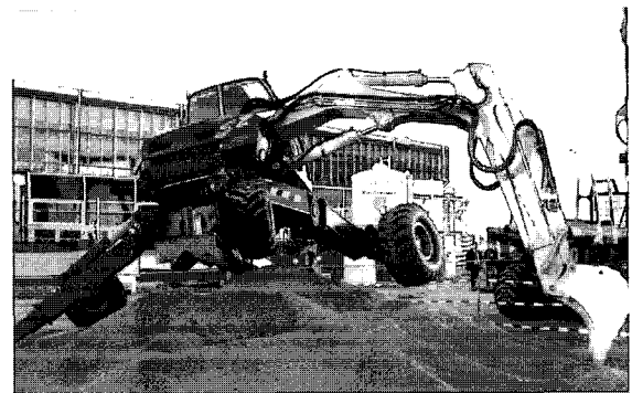
그림 10 스파이더 굴삭기(spider excavator)
