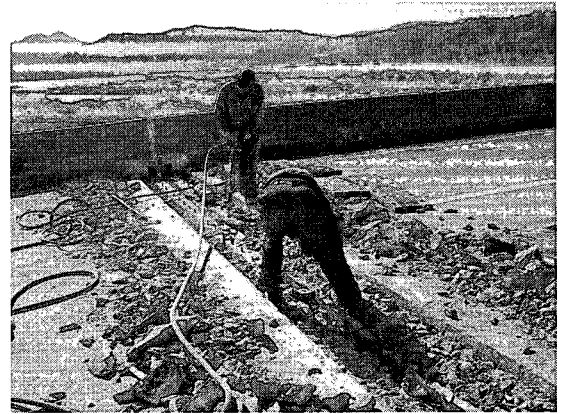
Fig. 4 상판분리작업의 모습.
