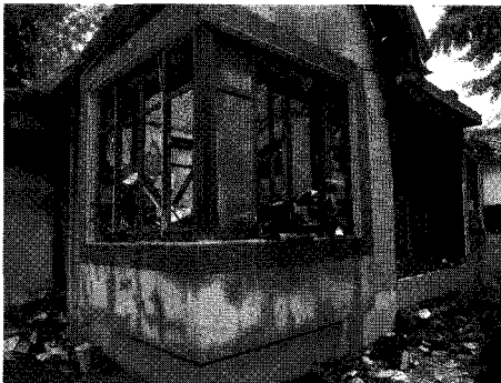
〈Figure 1〉 가옥 창문 및 출입문 상태.
