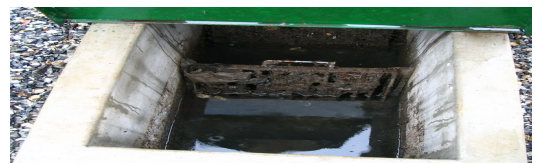
그림 3 마을 하수도의 스크린 설치 예
