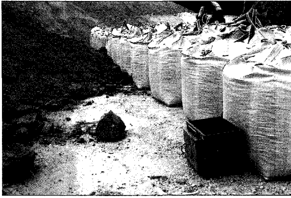
(a) 수평토압계 설치 장면
