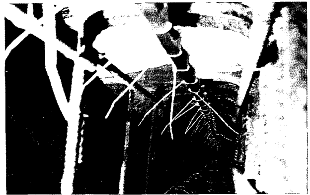
그림 12. 신설구조물의 Ti 리본 양극 그림
