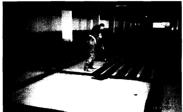
그림 13. 건물의 전도성 피복 양극 적용 모습
