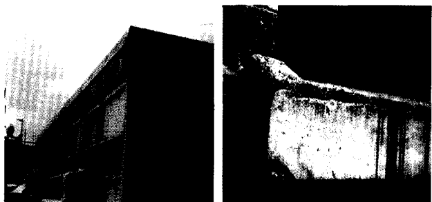
(c) 옥상파라펫 (d) 창대 사진 3. 건축구조물에서의 동해 피해 사례
