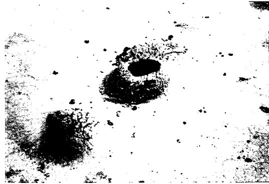
그림 4. 시트식 방수재에서의 기포
