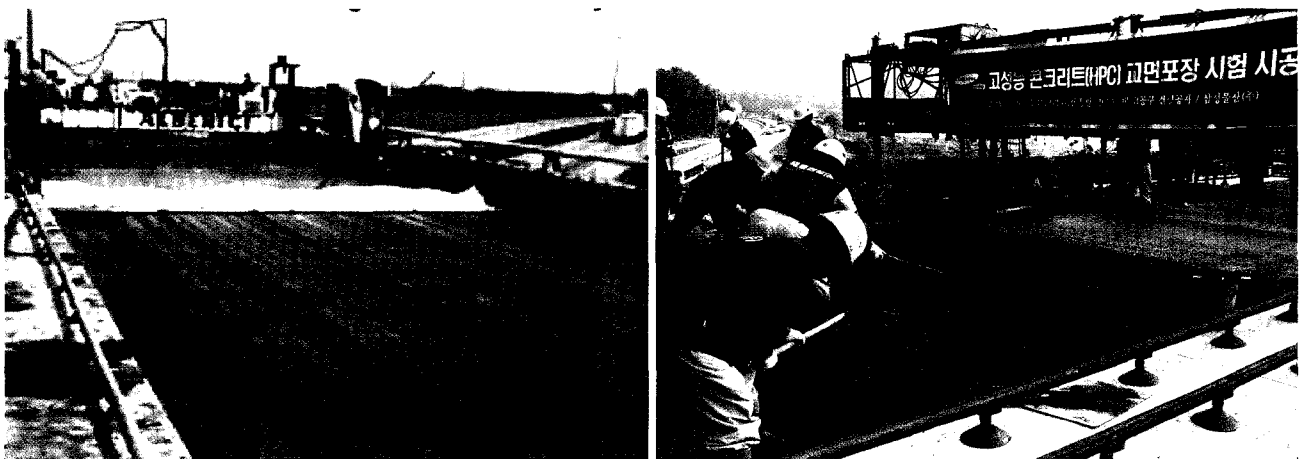
그림 2. 고성능 콘크리트 교면포장(overlay) 시공(해외/국내)
