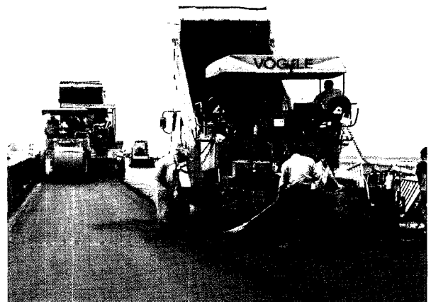
그림 1. 성수대교 표층 아스팔트 포장 전경(2004년)
