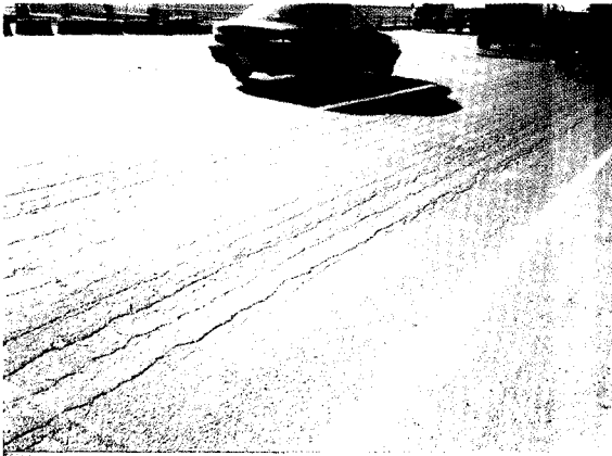
그림 6. 강바닥판 교량의 종방향 균열
