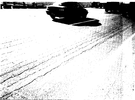
그림 7. 바닥판 포장층의 종방향 균열
