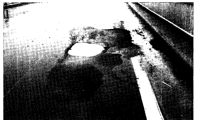
그림 2. 포트홀이 발생한 교면포장
