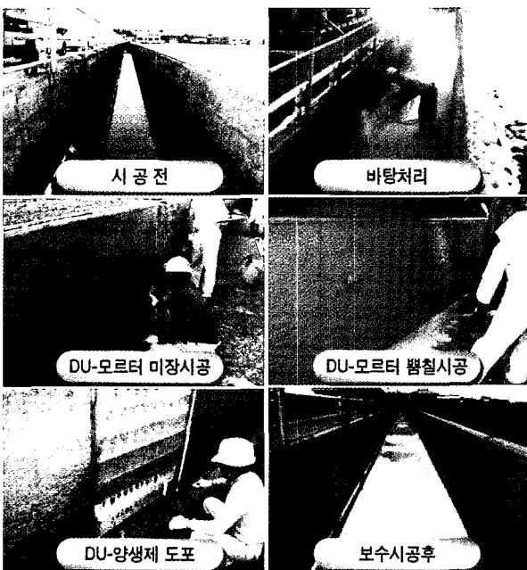
사진 7. DU-모르타르 라이닝 공법의 적용사례(농수로)
