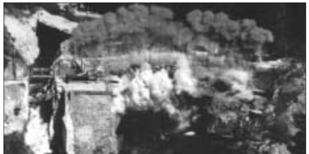
▲ 그림 9. 프랑스 St. Etienne de Vigan의 댐 철거 (좌: 1997년 철거 전, 우: 1998년 다이너마이트를 이용한 철거)
