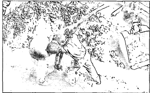
그림 21. 지중열교환기 설치 모습
