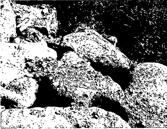
그림 5. 자연석 호안의 토사 흡출에 따른 공극 및 이로 인한 식생활착 불충분
