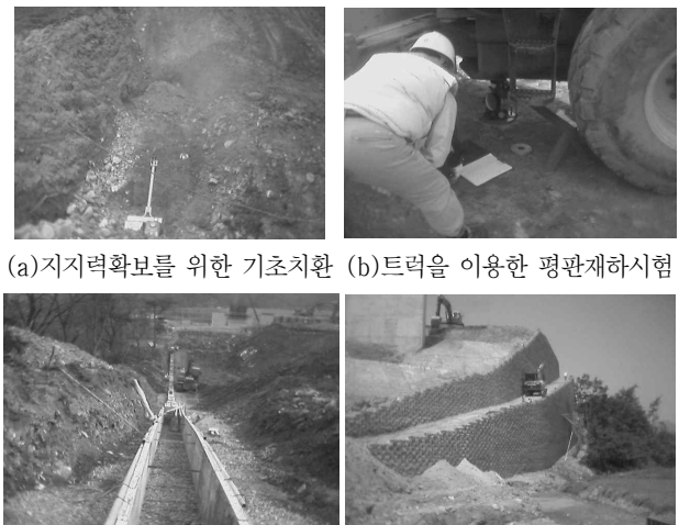
(c)기초치환 후 콘크리트 타설 (d)보강토옹벽 최종시공상태
