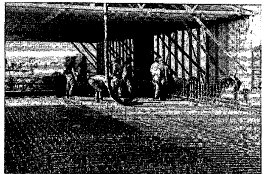
Fig. 10 CFRP로 부분 보강된 Taylor교의 상판.
