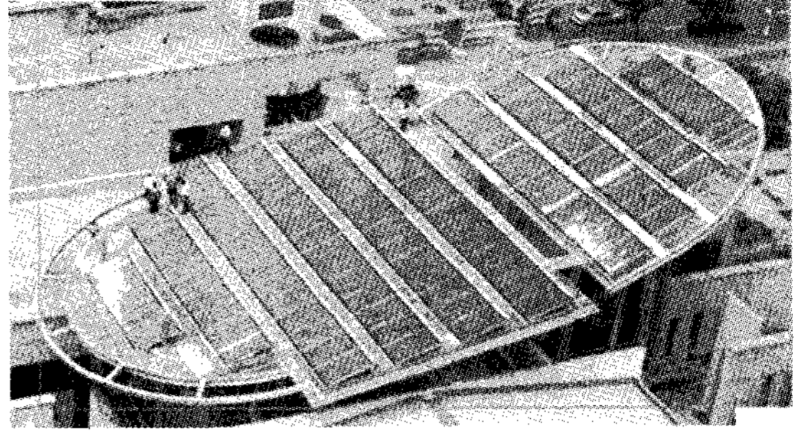
그림 3. 진공관형 집열기 설치 사진
