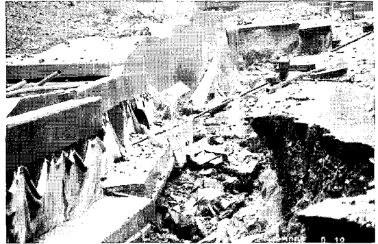
그림 3. 강원도내 하천변 도로 유실 사례
