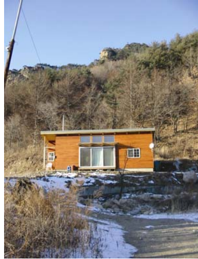
2005 인제 집짓기 14호 주택(인제 용대, 0512 주대관)
