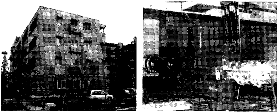
(a) 건물 전경 (b) MR 감쇠기의 설치
