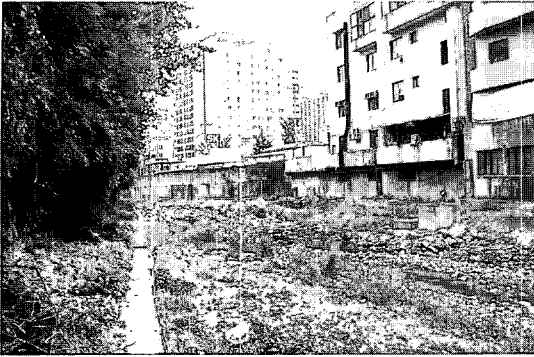
그림 2. 온천천 상류부 - 하천부지 경계에 건물의 벽체가 위치하고 지하실 창문이 계획홍수위 아래에 위치
