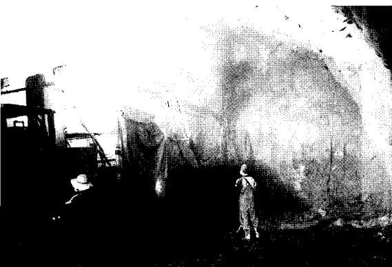
그림 1. 노현터널 전경 및 슛크리트 시공장면
