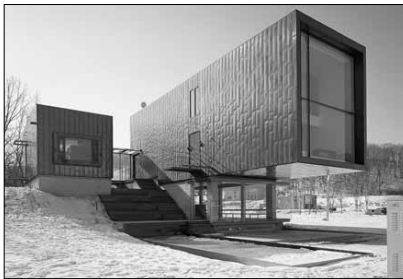
MOA갤러리+시경당 / 우경국(주, 예공 아트스페이스 건축)
