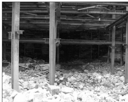
북측부 코너스트럿(9단) 설치
