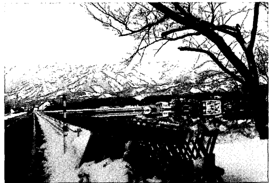
사진 2. 관리용 도로 및 보호시설
