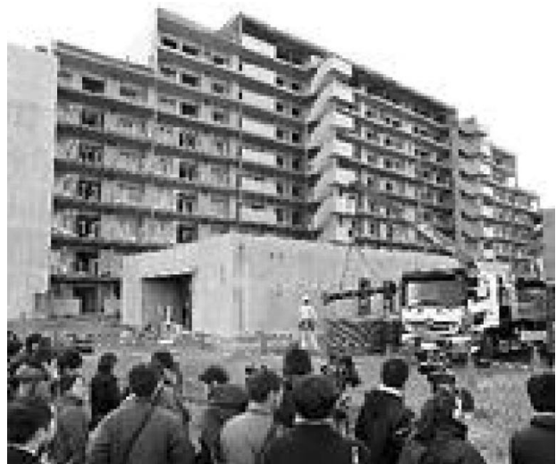
〈사진 2〉 해체작업이 시작된 라 베르두레 시라이 건물
