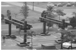
거푸집 지지틀 설치
