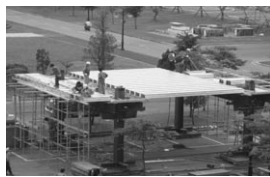
Deep Deck 설치
