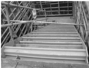
(그림 3) 시스템철골계단의 설치 모습
