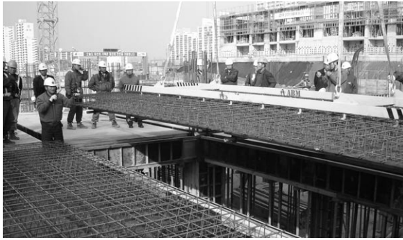
〈그림 2〉 PF/R 양중 및 설치 장면
