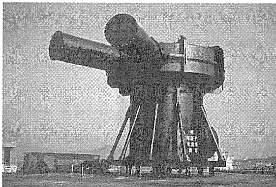
그림 8. 방류탑 (Multi-Nozzle Discharge Tower)
