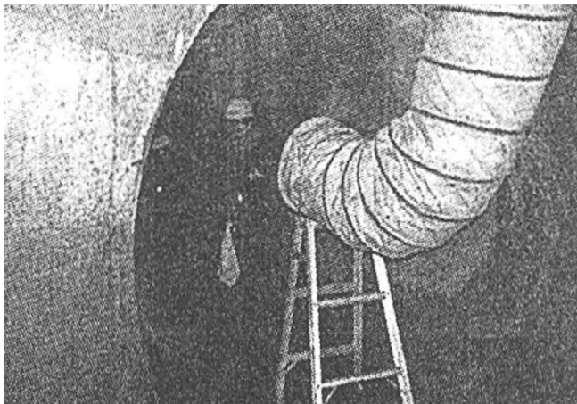
* 풍관(風管)말단을 관거내로 향하게 한 상태
