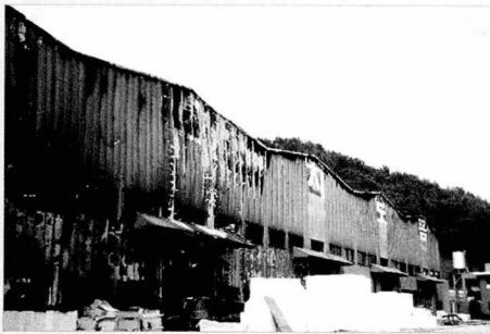
[사진 1] 화재 후 공장 전면부
