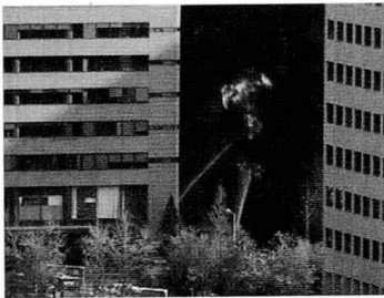
[사진 9] 냉각탑 화재 및 그 진화 광경
