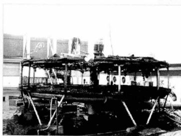
[사진 11] 금속제 골조만 남고 전소된 냉각탑 모습
