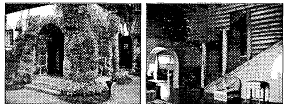
그림 15. 비뜨래스끄, 화강암으로 조적된 출입구 (좌) 및 통나무로 구축된 실내의 일부 (우)
