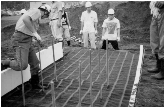
사진 1. 프리스트레스 설치
