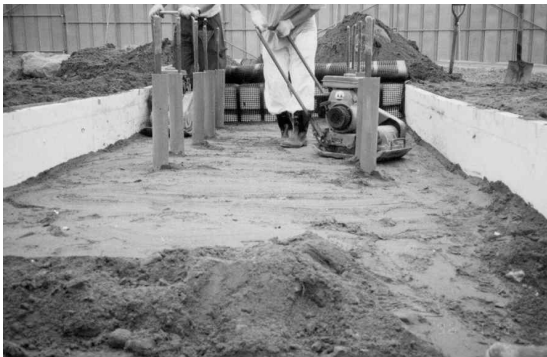
사진 2. 진동롤러를 이용한 성토 다짐
