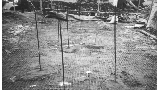
그림 6. 지오그리드포설 및 침하계 설치
