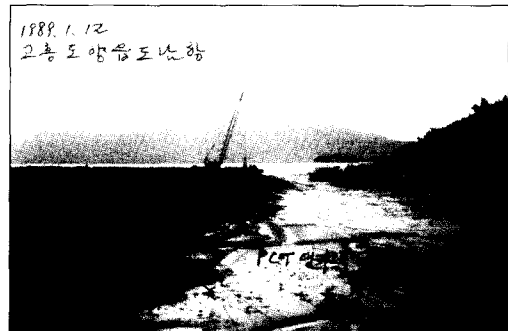
사진 1. PCT 말뚝의 수평변위 10~80cm 발생
