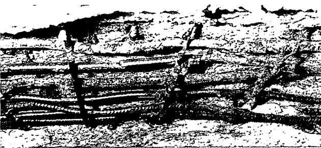
사진 2. 실 터널화재에 의한 세그먼트의 폭렬상황 (출처: Promat사 카달로그)
