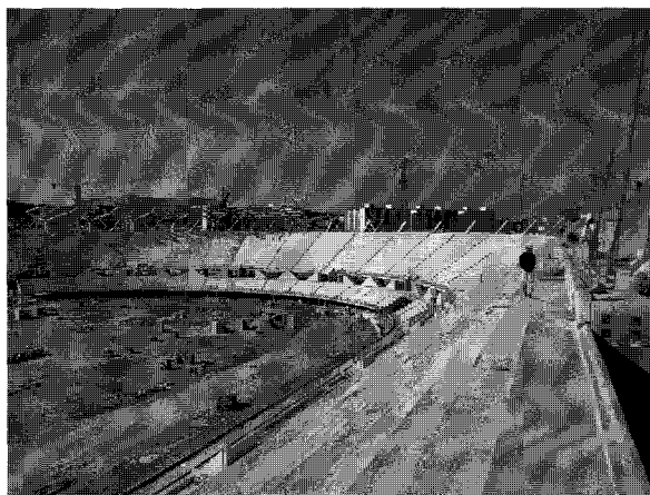
<그림 2> 공사 중인 스탠드 전경
