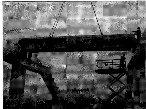
<그림 8> P.C 수평보 설치
