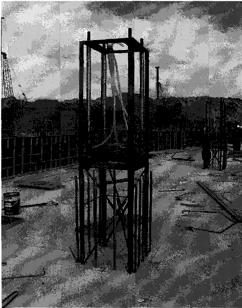
<그림 6> Anchor Frame 설치
