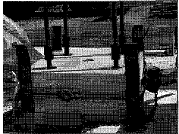
<그림 7> P.C 기둥 설치
