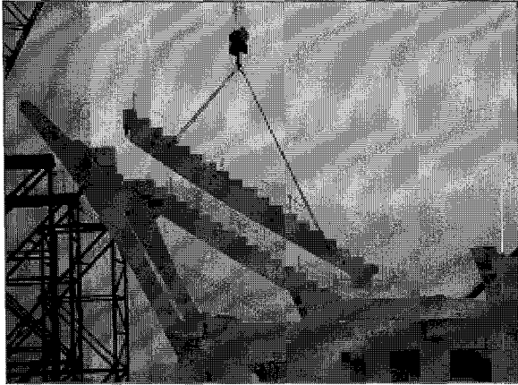
<그림 9> P.C 경사보 설치
