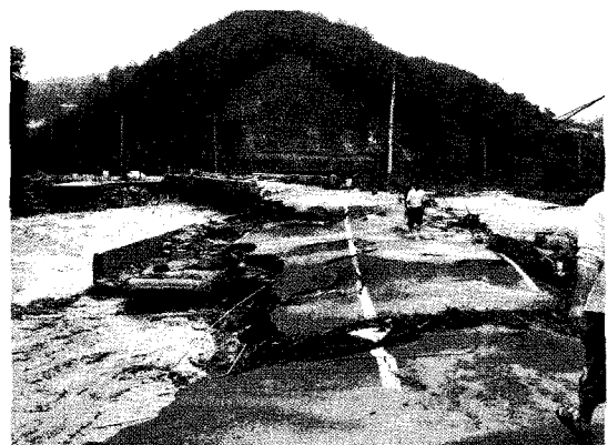
그림 2. 부안군 줄포면 침수로 인한 대피 및 장수군 천천면 계북천 인근 도로 유실 (8월 3일, 전라북도 치수재해대책과)
